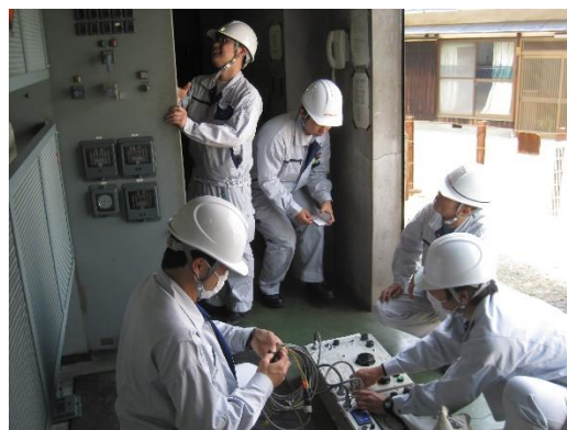
停電操作及び保護連動試験
