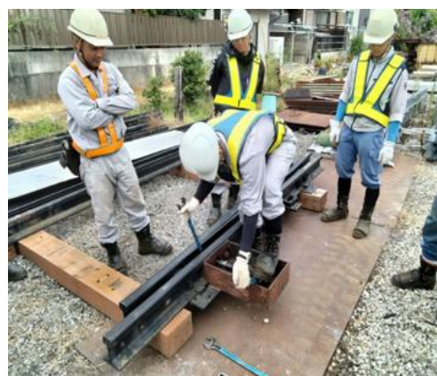
【保線】 スプリングロッド折損を想定した早期復旧訓練
