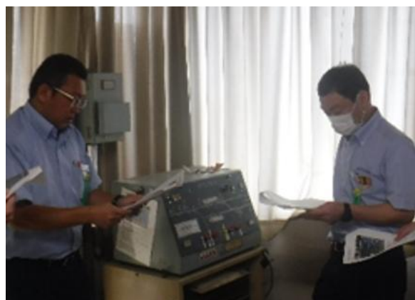
【駅務】連動盤取り扱い訓練
