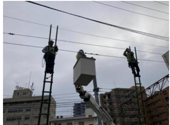
【電路】剥ぎ線取付訓練
