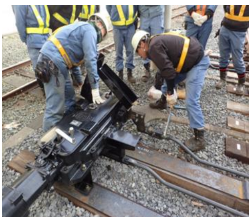
【保線】 ポイント転換不能を想定した早期復旧訓練
