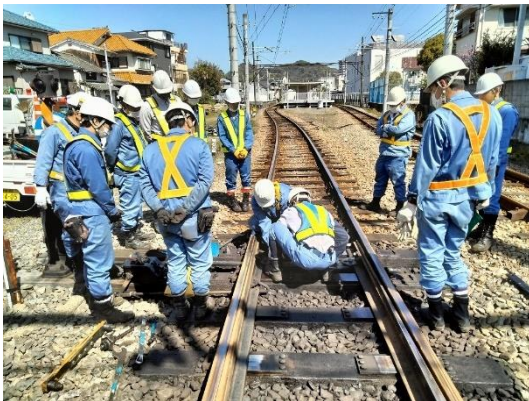
【保線】転てつ棒折損を想定した早期復旧訓練
