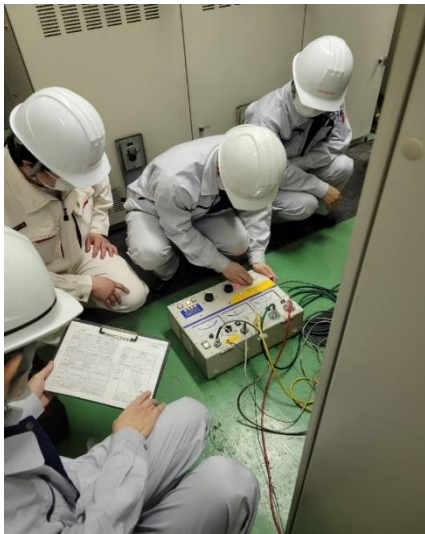
【電気】緊急点検訓練
