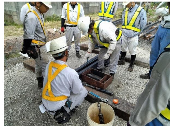
【保線】スプリングロッド折損を想定した早期復旧訓練
