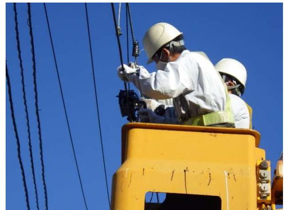
トロリーコンダクター不良を想定した早期復旧訓練
