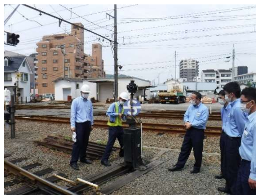
発条転てつ器の操作、点検訓練
