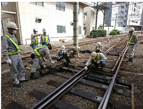
保線係員によるポイント転換不良復旧訓練
