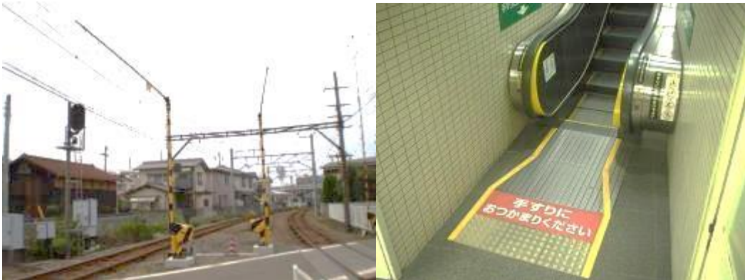
山西駅 上下線間遮断機設置
