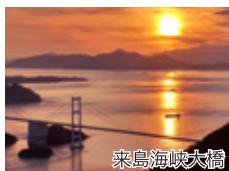
来島海峡大橋
