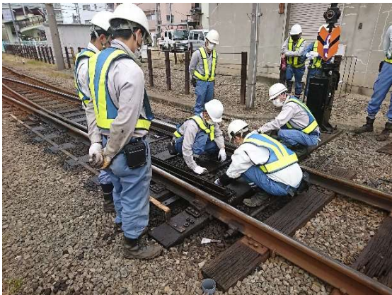
保線係員による転てつ棒折損を想定した復旧訓練
