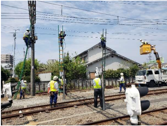
電路係員による吊架線・トロリー線張替訓練
