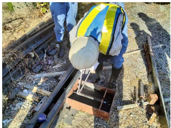
分岐器スプリングロッド折損を想定した復旧訓練
