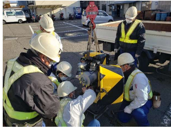
踏切遮断機取替訓練
