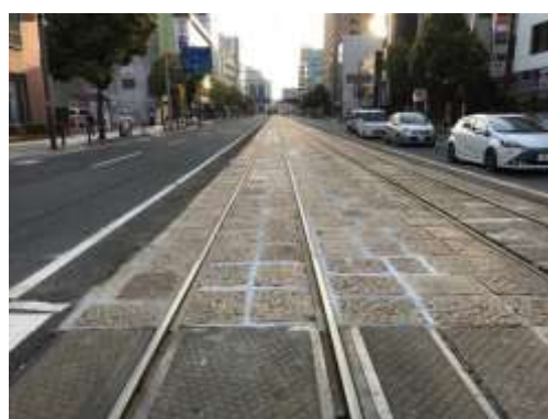
城南線、大街道～勝山町間 軌道修繕工事
