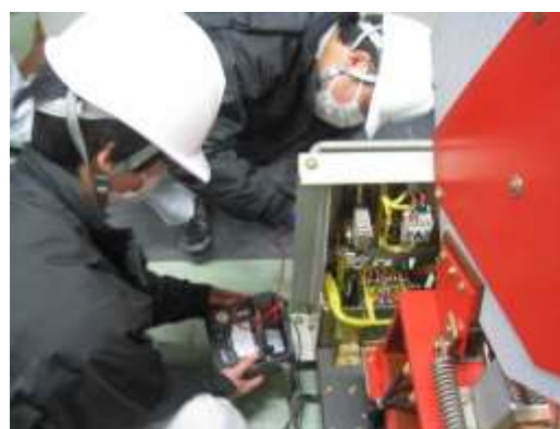
変電所設備復旧訓練
