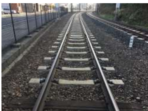
高浜線、港山駅～三津駅間 PCマクラギ敷設工事
