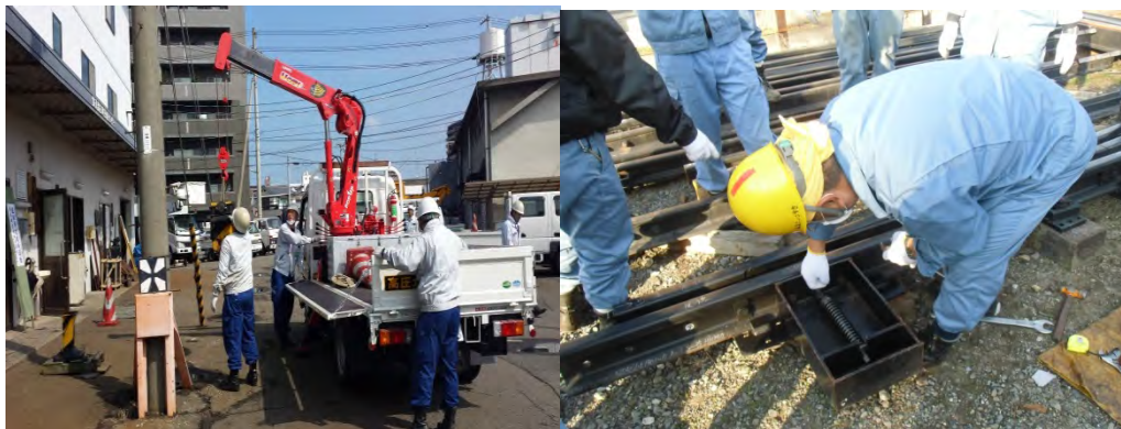
電気係実設訓練
