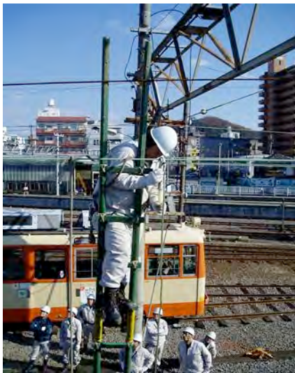
古町駅での架線修復訓練
