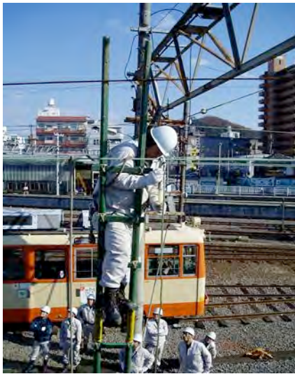
古町駅での架線修復訓練
