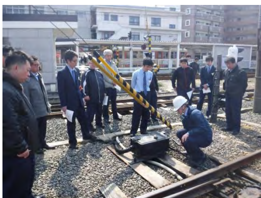
電気転てつ器の手動操作訓練
