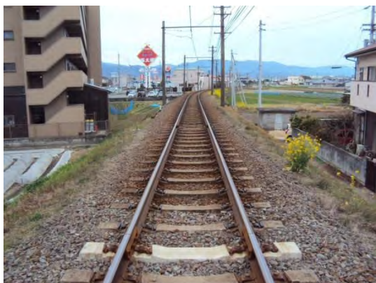
郡中線 レール交換(50kgN レール化)工事
