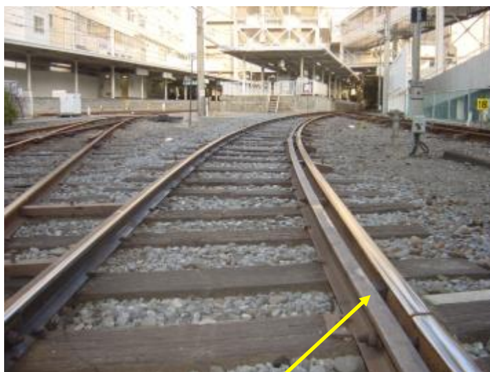
脱線防止用ガードレール
