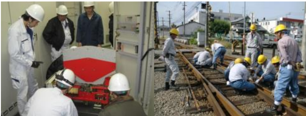
電気係実設訓練
