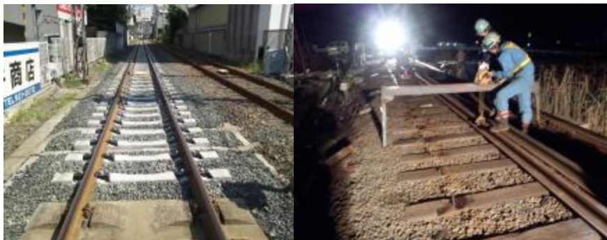
大手町～松山市駅間 PC枕木 田窪駅～見奈良間 レール交換
