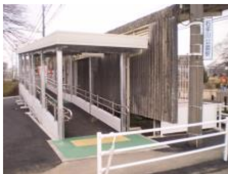
石手川公園駅 スロープ整備
