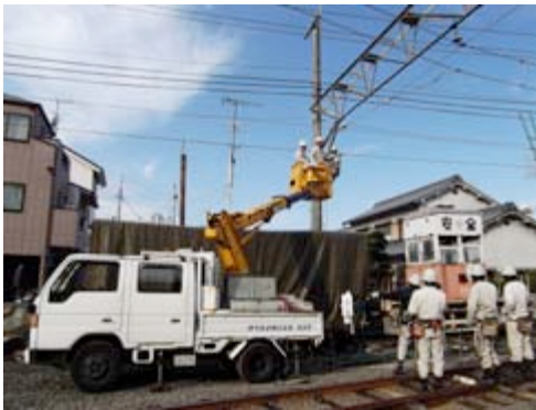
電気係実設訓練
